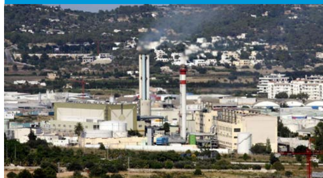
Central térmica GESA
